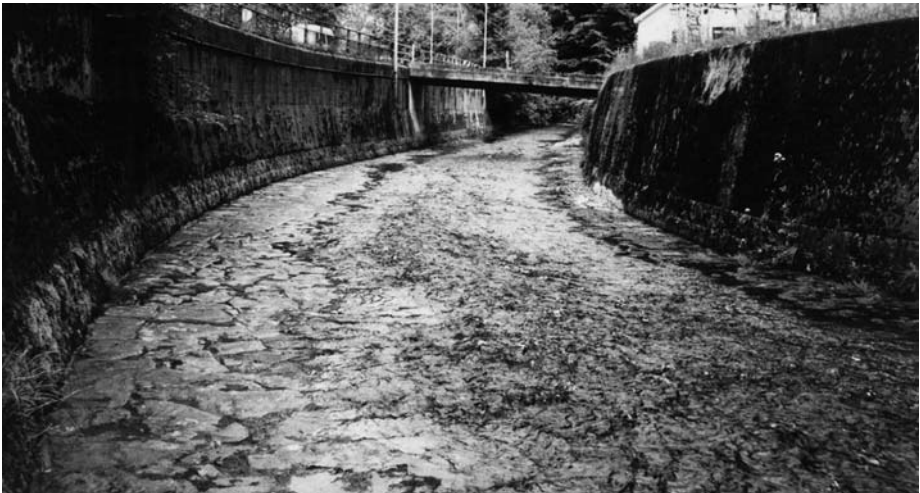
Fig. 2b: Cours d'eau avec un aménagement complet et imperméable du fond par un pavage de pierres.
